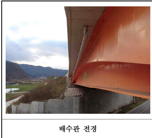
【사진 22.3.40】 배수시설 전경
