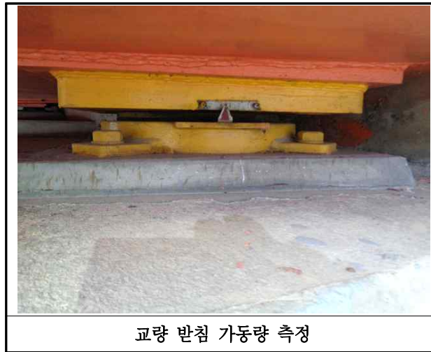
【사진 22.3.13】 교량받침 이동량 측정
