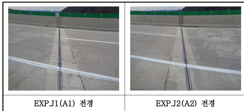
【사진 22.3.14】 신축이음장치 전경
