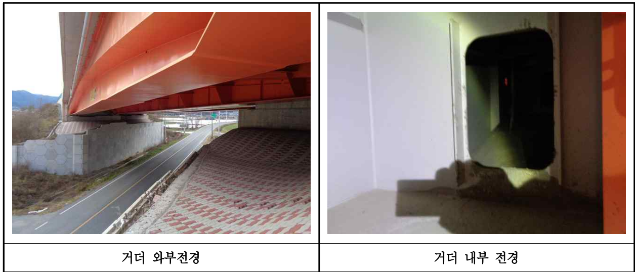
【사진 22.3.25】 거더 전경
