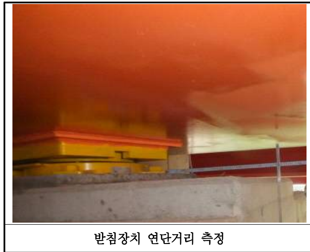
받침장치 연단거리 측정 【사진 22.3.12】 교량받침장치 연단거리측정
