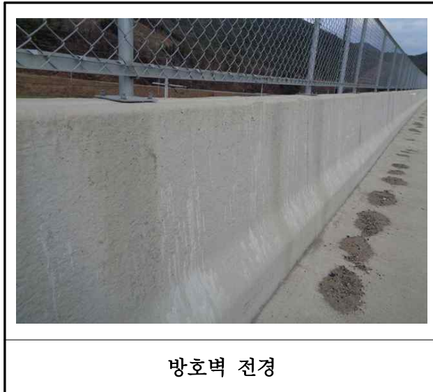
【사진 22.3.21】 방호벽 및 중앙분리대 전경
