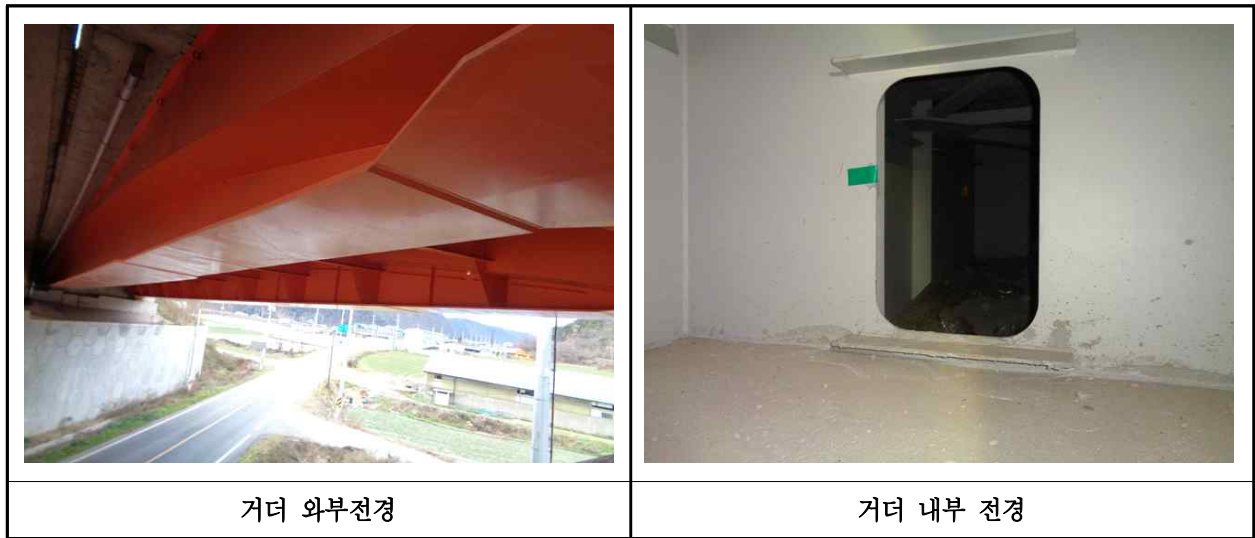
【사진 22.3.4】 거더 전경
