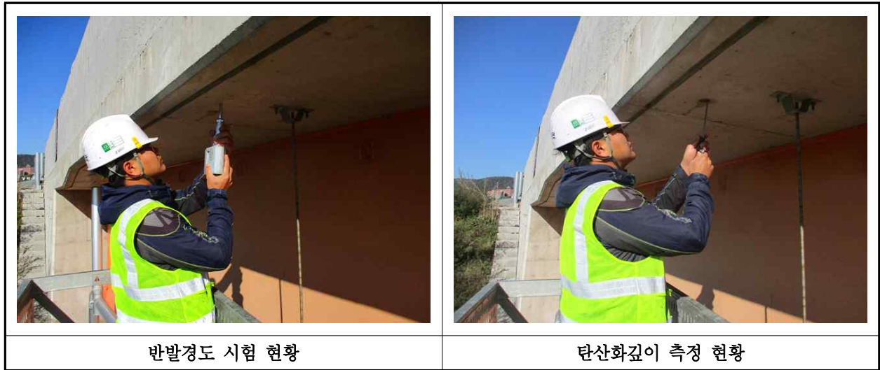
【사진 22.4.1】 콘크리트 내구성조사 현황
