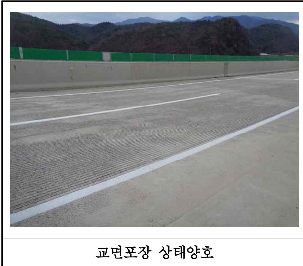
교면포장 상태양호 【사진 22.3.18】 교면포장 손상현황
