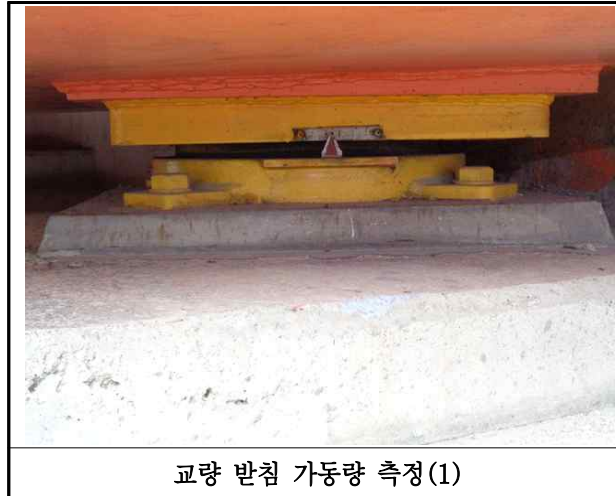
【사진 22.3.34】 교량받침 이동량 측정
