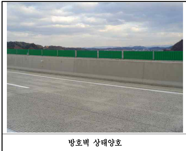
【사진 22.3.22】 방호벽 손상현황
