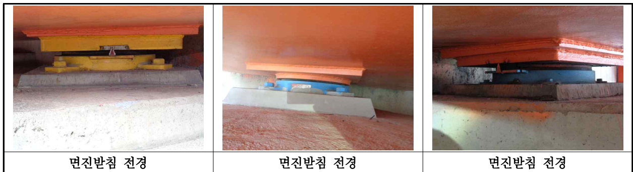
【사진 22.3.31】 교량받침 전경
