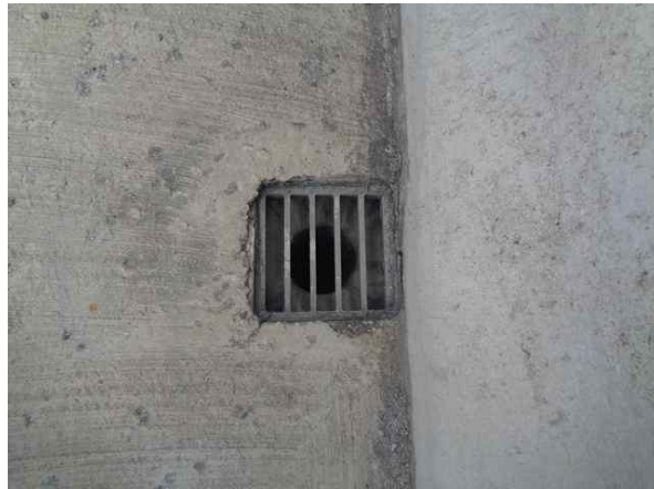
배수시설 상태 양호
