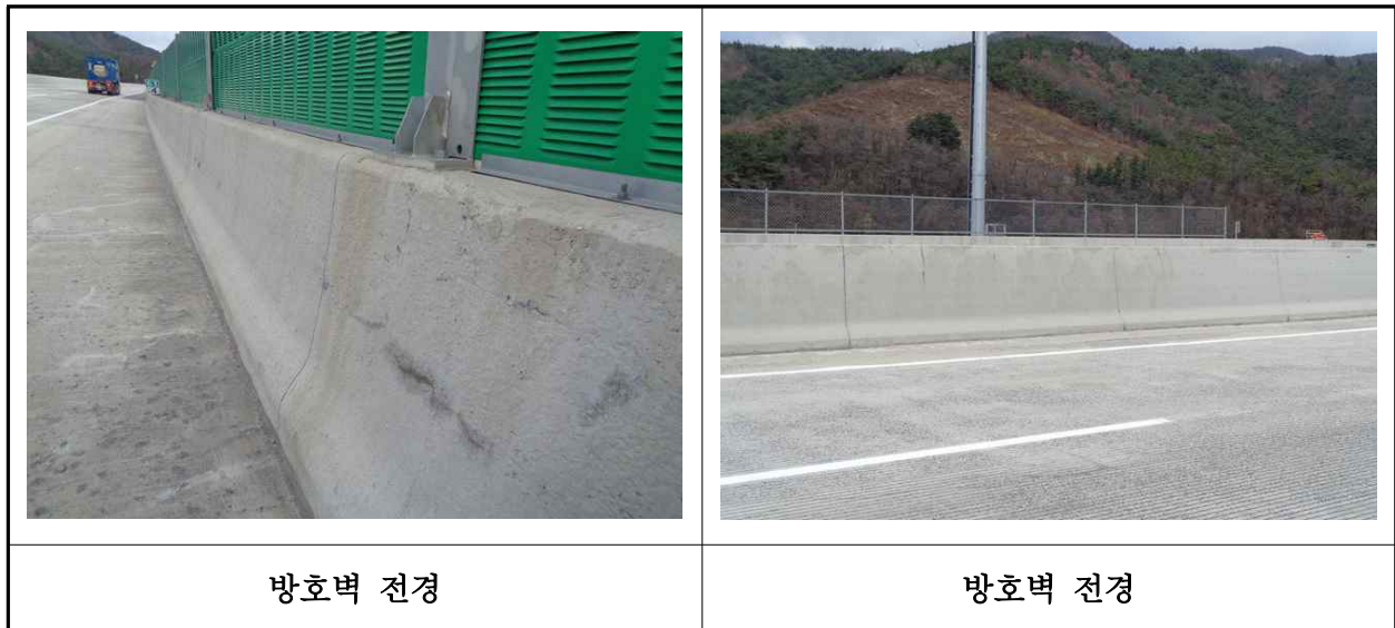
【사진 22.3.42】 방호벽 및 중앙분리대 전경
