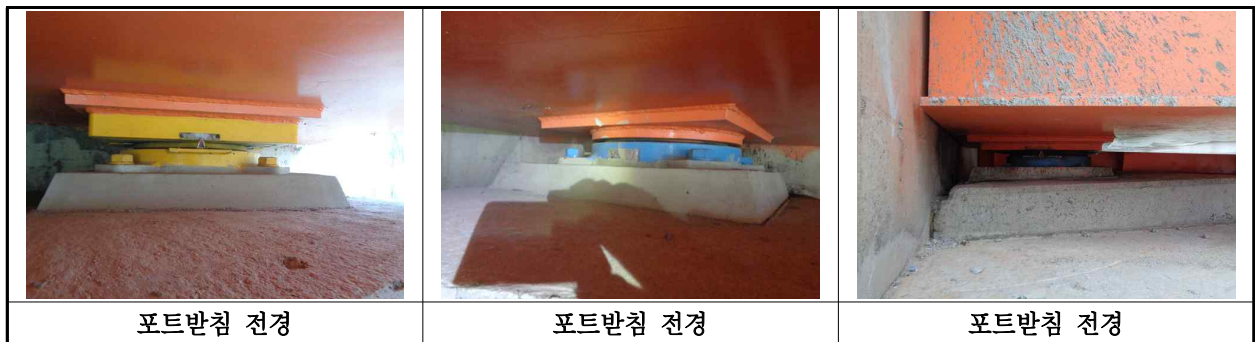
【사진 22.3.10】 교량받침 전경
