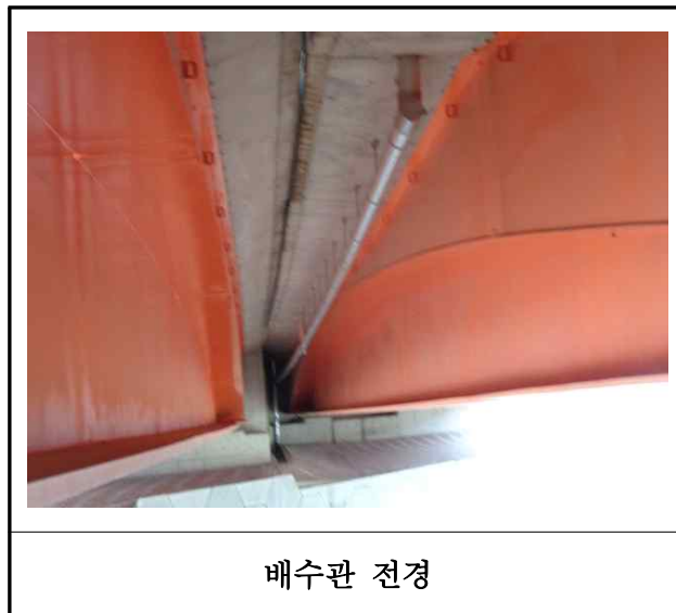
【사진 22.3.19】 배수시설 전경
