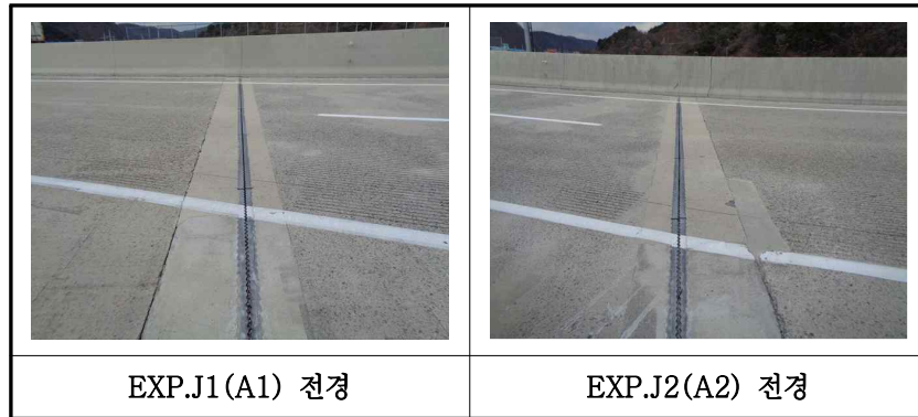
【사진 22.3.35】 신축이음장치 전경
